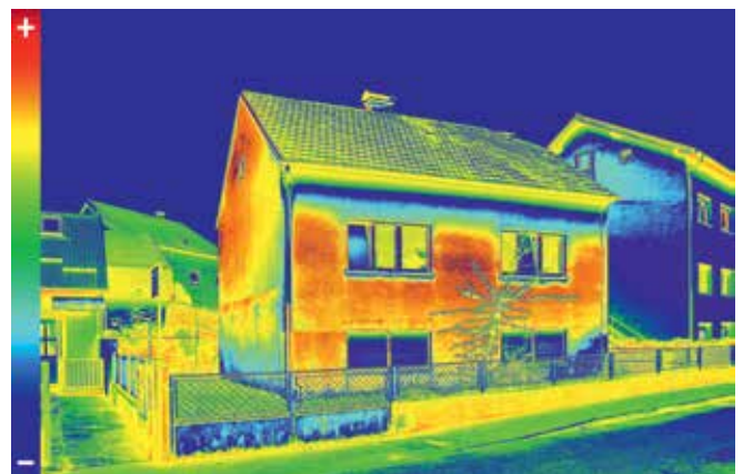
Termografický snímek obytného domu
